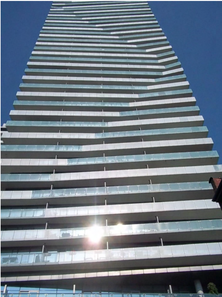
Figura 2 Edificación con muros cortina
