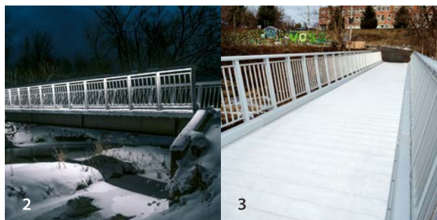
Fotos 1 a 3: El tablero GuardDECK™ de puente en aluminio con barandillas, esquema y ejemplos https://maadigroup.com/upload/documents/MAADI_Group_Light_Metal_Age_August_2019_article.pdf
